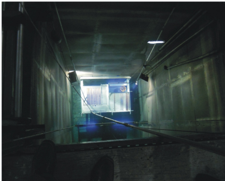
Fondo de la piscina: maniobra para la recarga de cobalto-60
